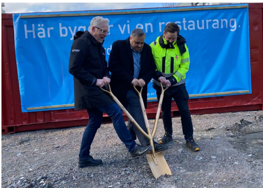
Gårdstensbostäders vd Ulf Merlander, Fayz Majzoub som ska driva restaurangen och Petri Aspegren från Vi Bygg lyckades gräva en liten grop i det hårda underlaget.
