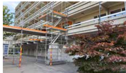
Entreprenören MVB Väst AB har etablerat sig i området och ställningar har rests på Kastanjgården för arbetet med att göra om lokaler till lägenheter.
