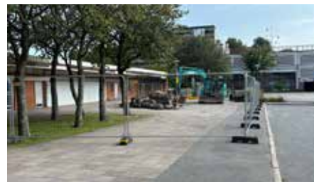
Grävskopan är på plats för att göra markarbetet.
