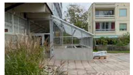
Ett av växthusen under byggnation
